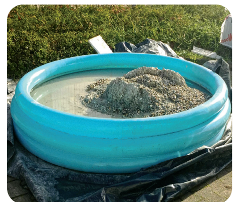
Waschplatz und Zwischenlagerung von Restbeton
