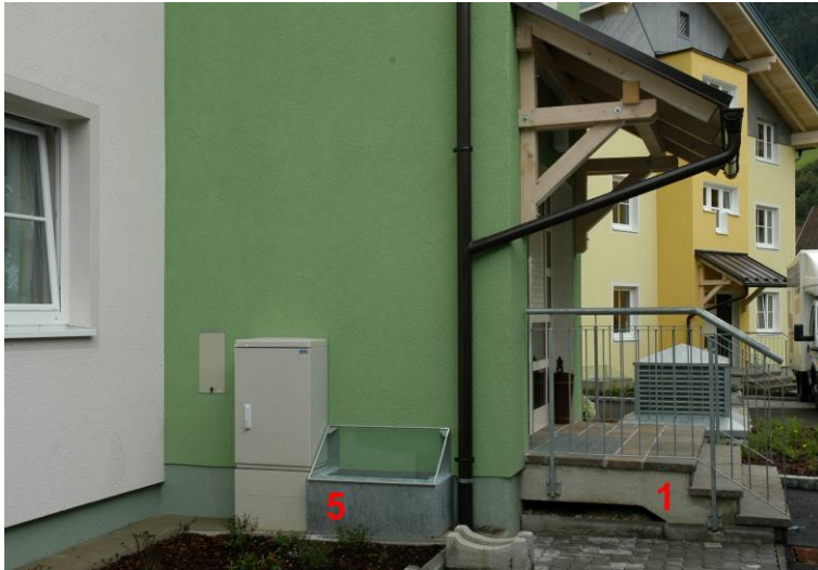
Abb. 5.20: Erhöhte Anordnung der Hauseingänge; hochgezogene Kellerlichtschächte, Entlüftungen und Verteilerkästen (siehe Legende zu Abb. 5.19); aus [9]
