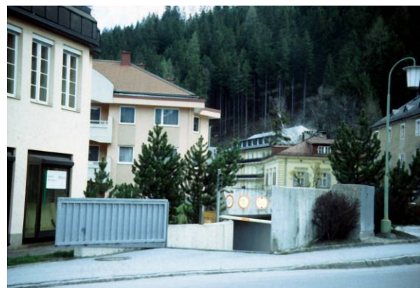
Abb. 5.8: Einfahrt einer Tiefgarage, die durch ein Schwenktor gegen Wassereintritt gesichert werden kann (Quelle: die.wildbach); aus [9]
