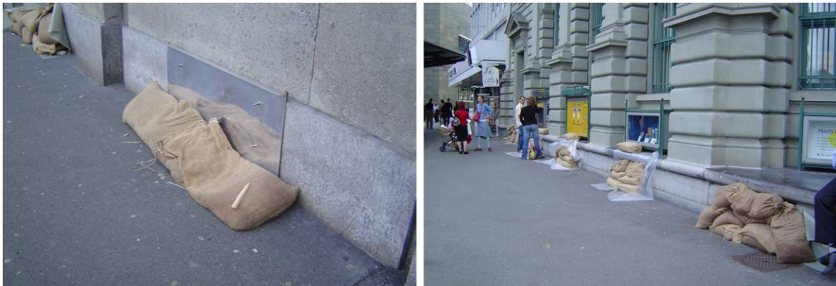
Abb. 5.17: Abdichtung von kleineren Öffnungen mittels behelfsmäßiger Sofortmaßnahmen (Beispiele): (A) Abdichtung von Kellerfenstern mittels Sandsäcken; (B) Abdichtung mittels Stahlplatte und Sandsäcken (Quelle: BMLFUW); aus [13]
