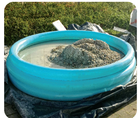
Waschplatz und Zwischenlagerung von Restbeton
