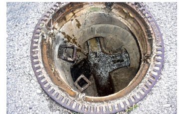
Anschlußschacht
