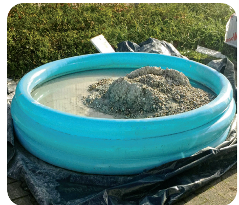
Waschplatz und Zwischenlagerung von Restbeton
