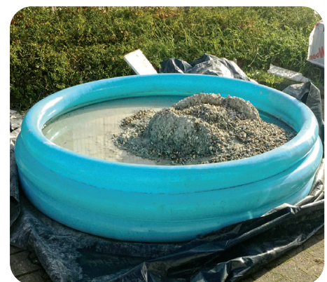
Waschplatz und Zwischenlagerung von Restbeton
