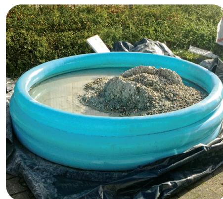
Waschplatz und Zwischenlagerung von Restbeton
