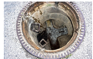
Anschlußschacht
